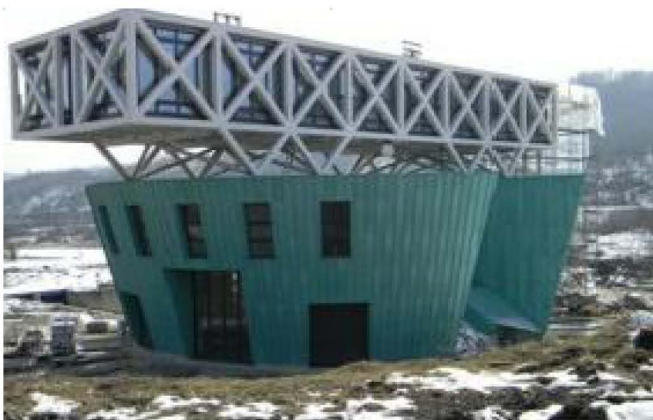
MHC Lunca Cornului - Vedere exterioară
