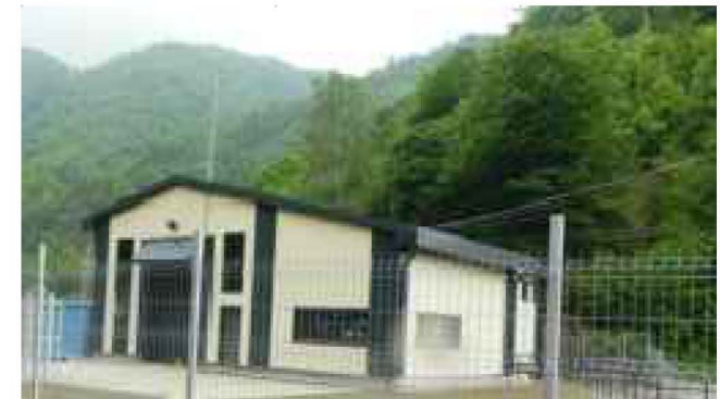
MHC Sadu A - Vedere exterioara
