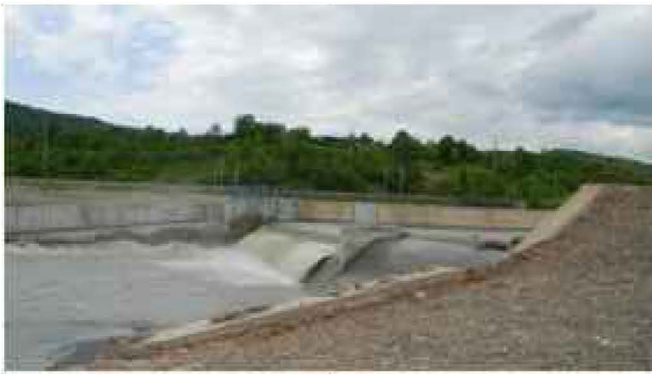
Prag captare Breaza pe Raul Prahova. Q_{\text{captat}} = 9.2 \text{ mc/s}
